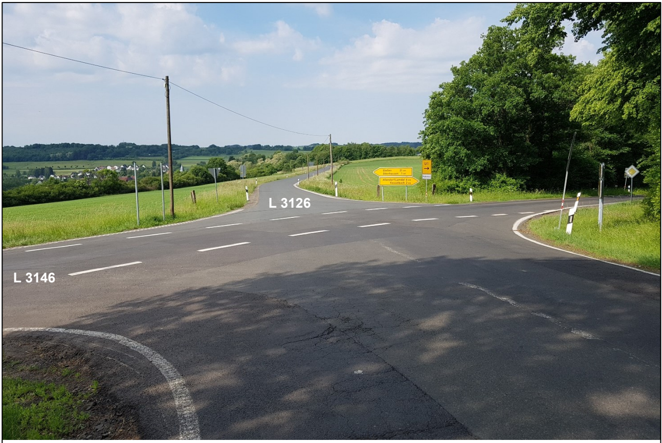
Abbildung 3. Knotenpunkt L 3126 / L 3146 (Blick nach Südwesten bzw. Odenhausen).
